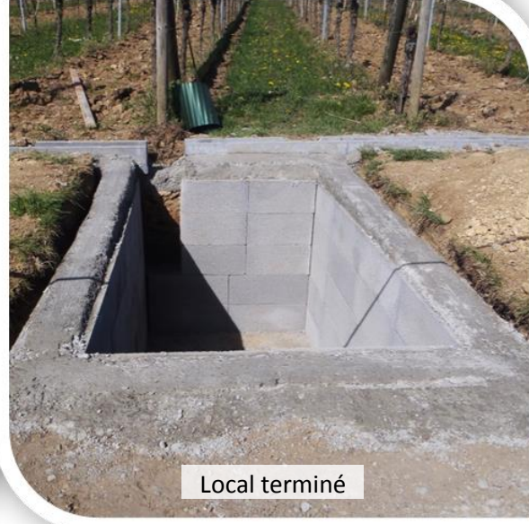
Mise en place du caniveau en béton
